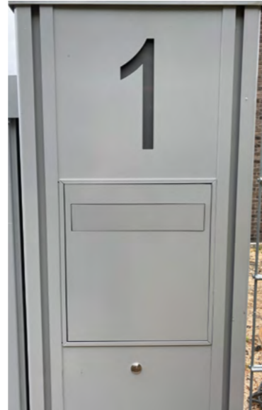
3:: Vhozdová klapka zapuštěná, číslo domu s otevřeným laserovým výřezem
